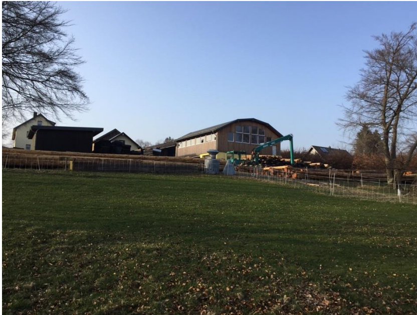
Betriebsgelände von südlicher Wiese (Quelle: KRINGS ARCHITEKTUR+STADTPLANUNG)
