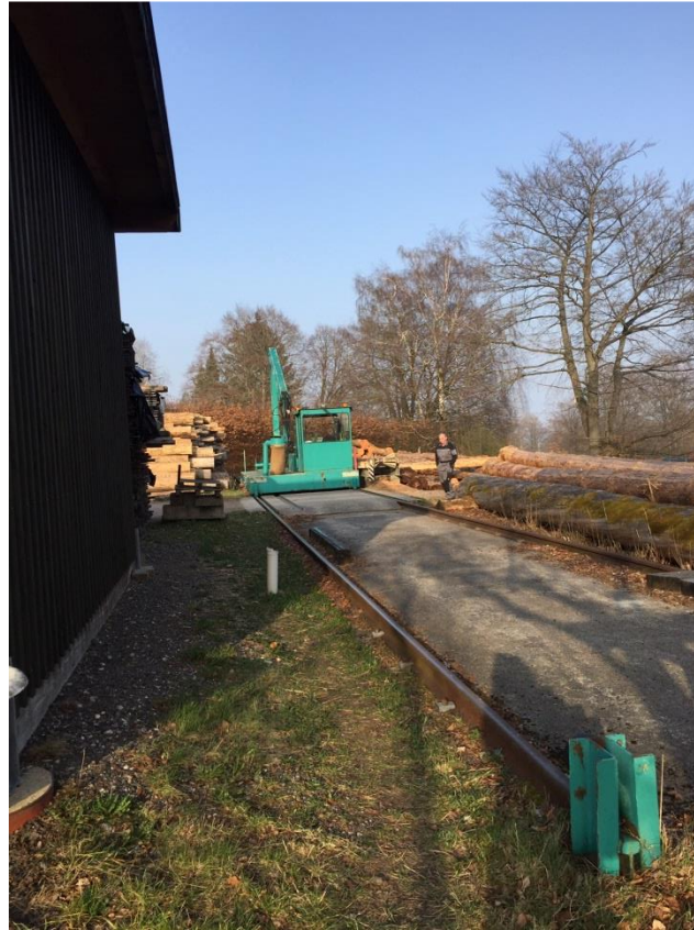
Rundholzsortier- und Kappanlage südlich des Sägewerkgebäudes (Quelle: U. Krings)
