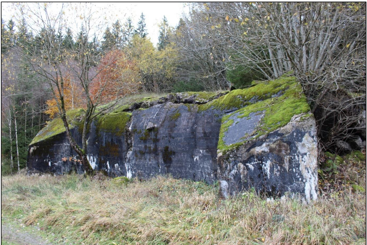
Abb. 10: Ehemaliger Gefechtsstand südlich des Plangebietes.
